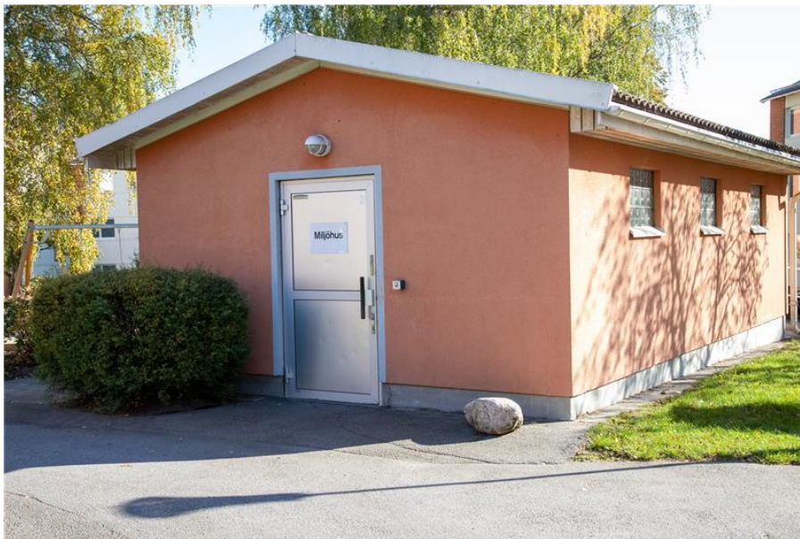
Figur 2 Avfallsrum med ljusinsläpp.
