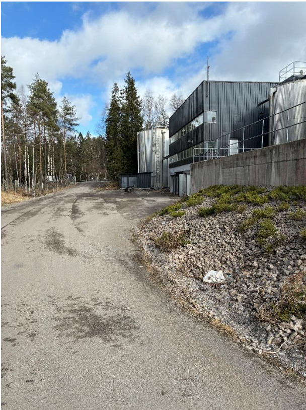
Figur 7-4 Förbehandlingsanläggning för matavfall. Sweco 2026-03-12.
